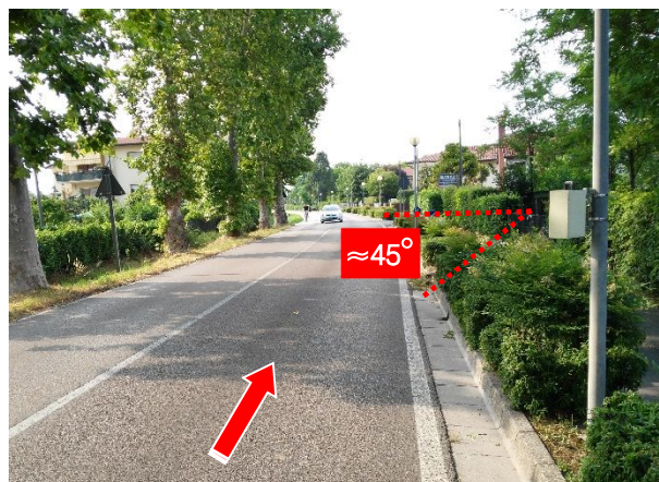
Figura 3.2 – Angolo di installazione dei radar rispetto alla direzione di marcia
