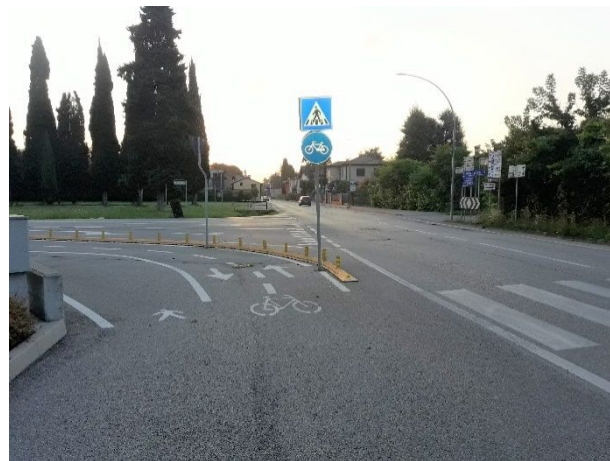
Figura 2.3 – Fine percorso ciclo-pedonale di Via Valsugana
