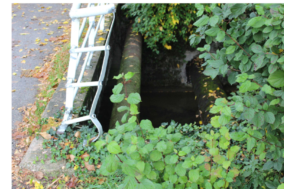
FOTO 3 Vista della condotta di fognatura presente nell'alveo
