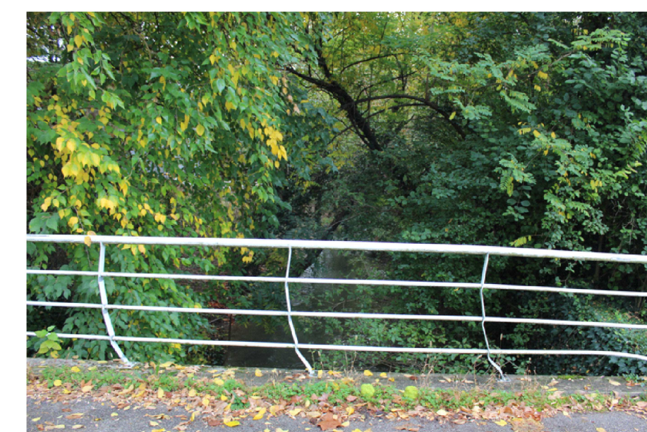
FOTO 1 Vista della Roggia Musonello dal ponte esistente
